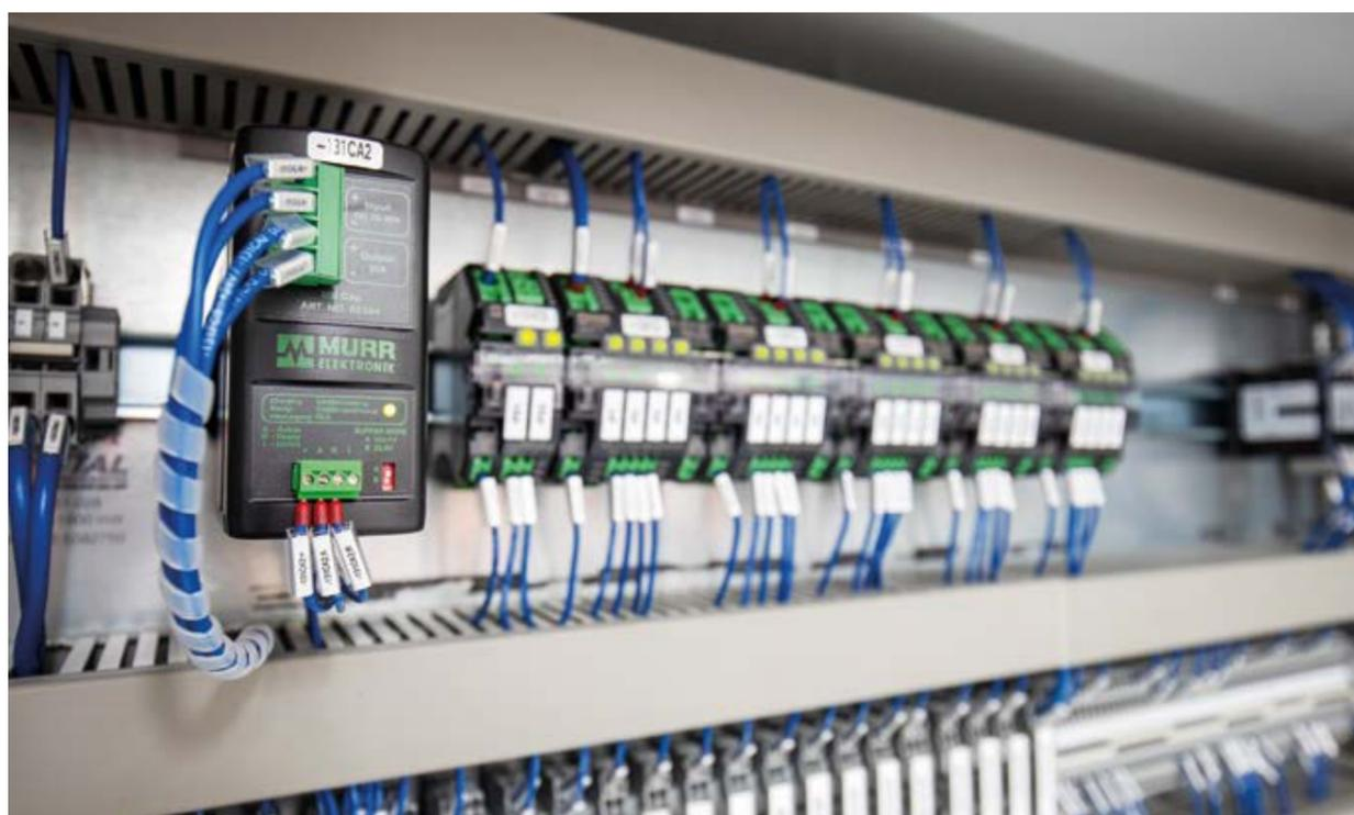
Coup d'œil dans l'armoire de commutation avec le module tampon MB Cap
